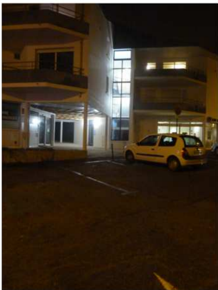
Photo 3: vue de nuit d'un immeuble de deux étages place Anne de Bretagne, photo prise à environ 15 mètres du bâtiment.
